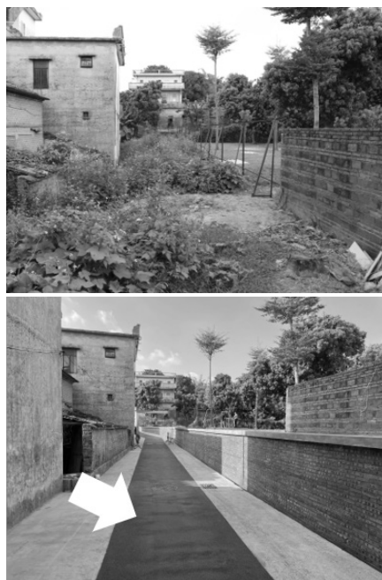
图4 生态公园道路透水路面(上:改造前 下:改造后)
